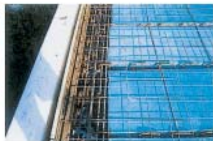
Completamento della struttura con armatura integrativa per le travi principali e con stesa di rete elettrosaldata
