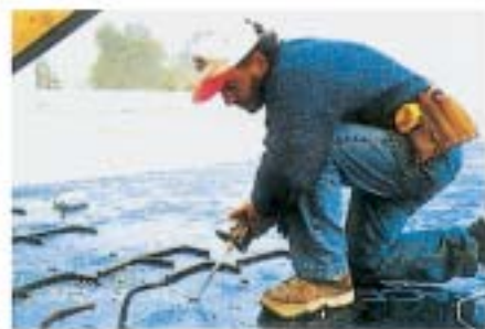
Resinatura dei fori con pistola manuale ed infissione dei connettori
