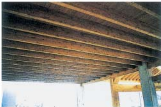
Rivestimento dell'ossatura lamellare in abete
