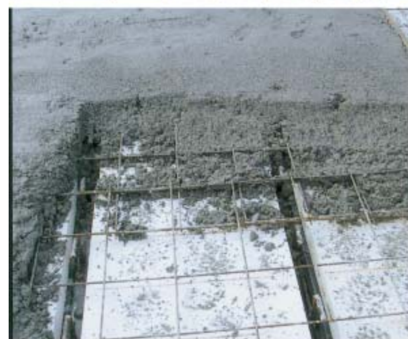
Foto sotto: il completamento del solaio con la formazione del massetto con calcestruzzo Rck300
