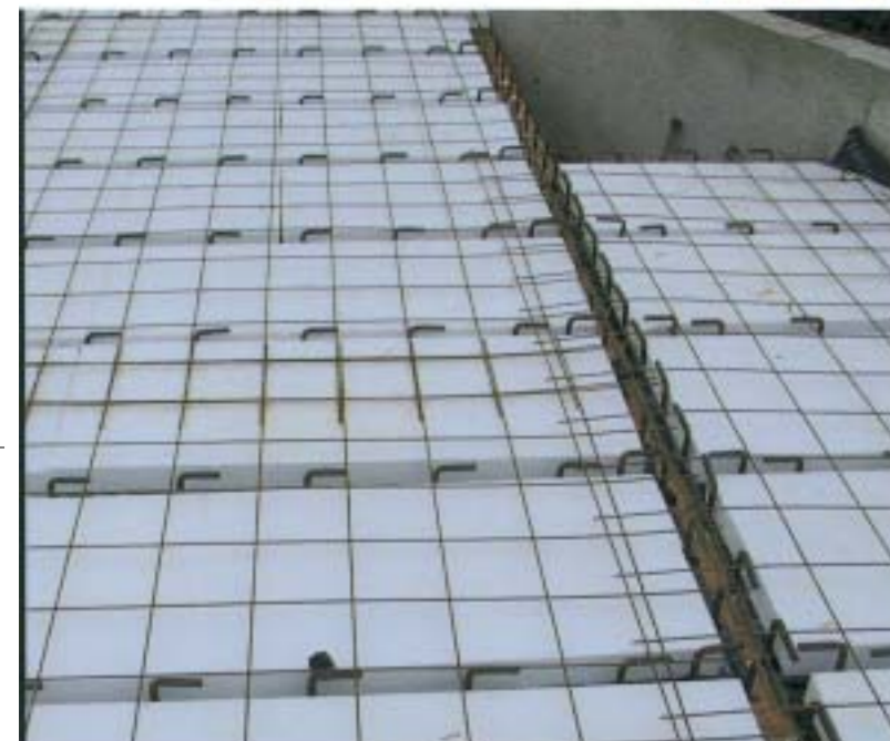
Foto in senso orario partendo in alto a sx: la posa dei pannelli OSB classe 3 e la successiva posa dei pannelli isolanti in polistirene espanso sinterizzato da cm 8 di spessore
